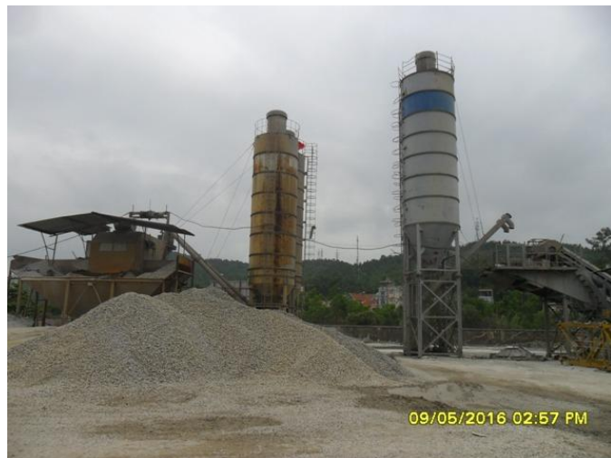
(Làm móng và bắt đầu xây dựng trường)
